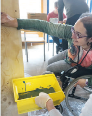
Imprägnierung mit Öl
